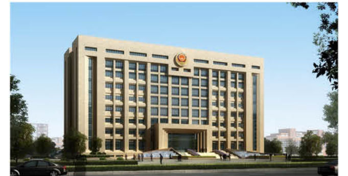
项目名称: 江西某公安局 所属行业: 通信、数据中心 安装容量: 1600A 治理对象: UPS、变频器
