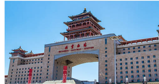
项目名称: 北京西站 所属行业: 轨道交通 安装容量: 1200A 治理对象: UPS、变频器
