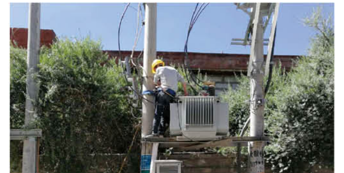
项目名称: 西藏电网项目 (海拔 3000 米以上) 所属行业: 国网电力 安装容量: 11600kVar (86台) 治理对象: 不平衡台区
