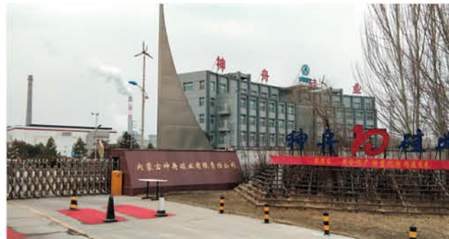
项目名称: 神州硅业项目 安装容量: 6600A 所属行业: 非金属制造化工 治理对象: 蓝宝石长晶炉
